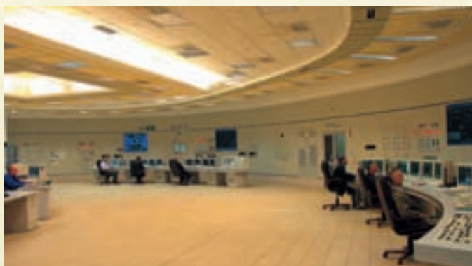
Control room 500 MW 2 in Elektrownia "Kozienice" S.A.
