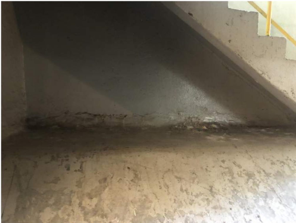
Zdjęcie nr 13 Elektrownia Bledzew – przesiąkanie wody.
