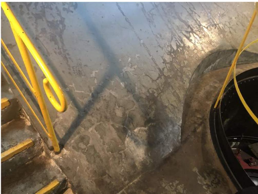
Zdjęcie nr 13 Elektrownia Bledzew – przesiąkanie wody.
