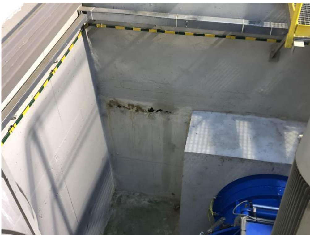
Zdjęcie nr 4 Elektrownia Likowo – HZ 2.
