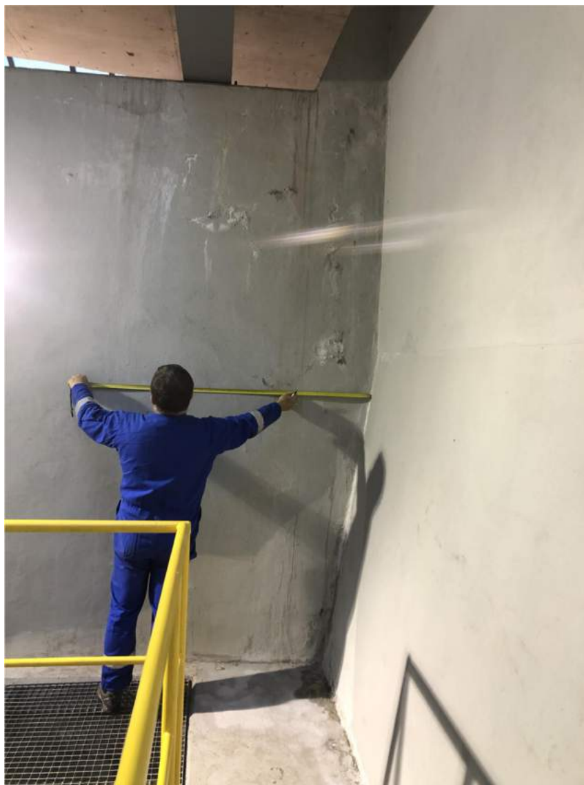
Zdjęcie nr 1 Elektrownia Likowo – HZ-1.
