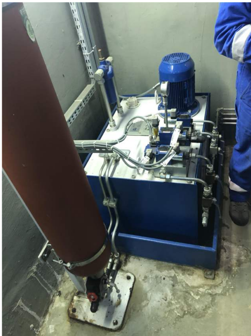
Zdjęcie nr 7 Elektrownia Rejowice – do wykonania iniekcji konieczne jest przestawienie agregatu hydraulicznego na HZ 1 i HZ 2.
