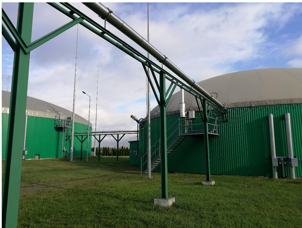
Rys. 8. Szeregowy transport biogazu między zbiornikami.
