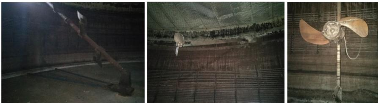
Rys. 6. Mieszadła w zbiornikach procesowych Biogazowni Gorzesław, od lewej: skośne prętowo-łopatowe, skośne prętowe Peters, zatapialne.
